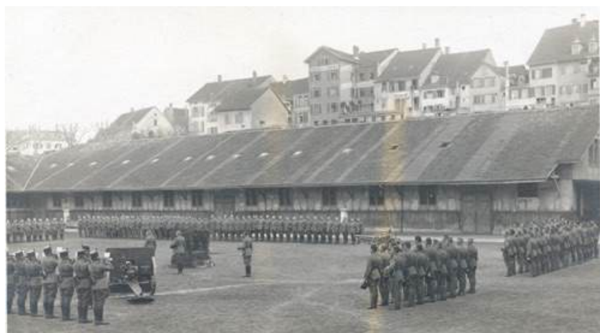
Die Stallungen und der Kasernenhof von 1865, im Hintergrund die Vorstadt
