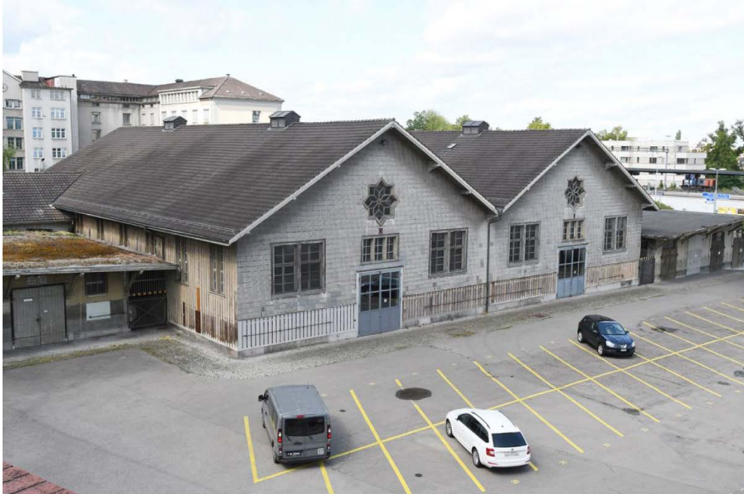
Doppelreithalle: Einsicht aus Oberer Mätteli (De Carli-Lanfranconi und Marinowitz, 2024: Gutachten Schutzzumfang Doppelreithalle Bahnhofstrasse 80+)
