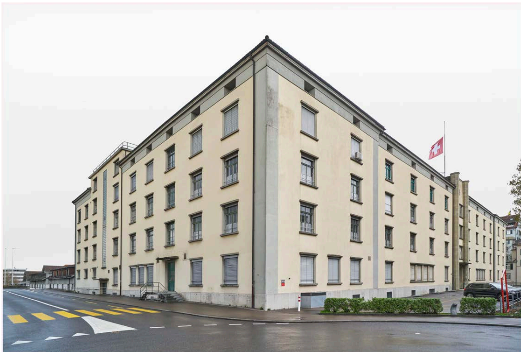
Hauptgebäude: Ansicht von der Bahnhofstrasse, Richtung Nordosten ( wirsindstadtkaserne.ch )
